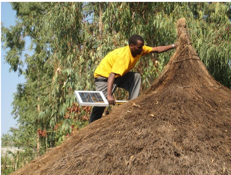
Mit der Kompensation ihrer Treibhausgas-Emissionen ermöglicht die TKB die Installation von 1884 Solarpanels auf den Hausdächern äthiopischer Familien. Quelle: Stiftung «myclimate»
